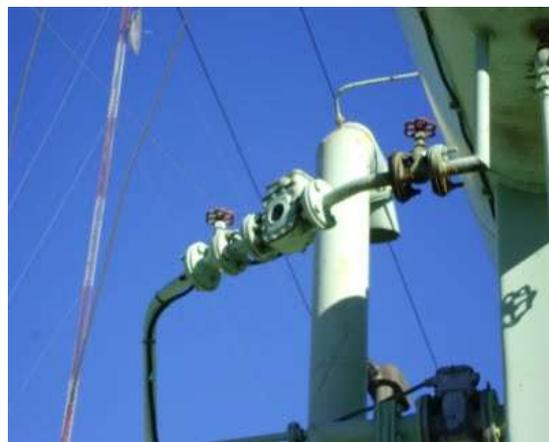
El relé tiene un sistema de purga de gases y un pulsador de prueba para el flotante inferior y superior. Pulsando lentamente suena la alarma y si se pulsa violentamente manda desenganche. Además existe un orificio por el cual se inyecta un gas simulando una falla incipiente o una falla violenta, esta última es la manera correcta de probar el relé.
